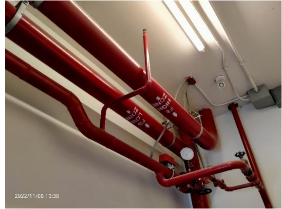
รูปที่ 2.3-14 ระบบท่อน้ำดับเพลิงหรือท่อยื่น
