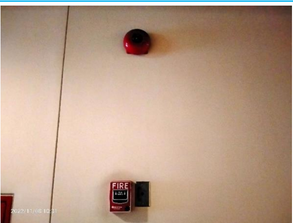
รูปที่ 3-44 อุปกรณ์แจ้งเหตุเพลิงไหม้แบบมีอกกด และอุปกรณ์ส่งเสียงสัญญาณแจ้งเหตุอัคคีภัย
