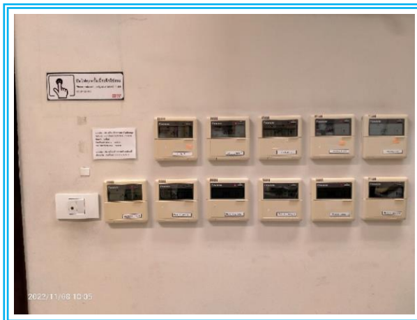
รูปที่ 3-28 เทอร์โมสแตท
