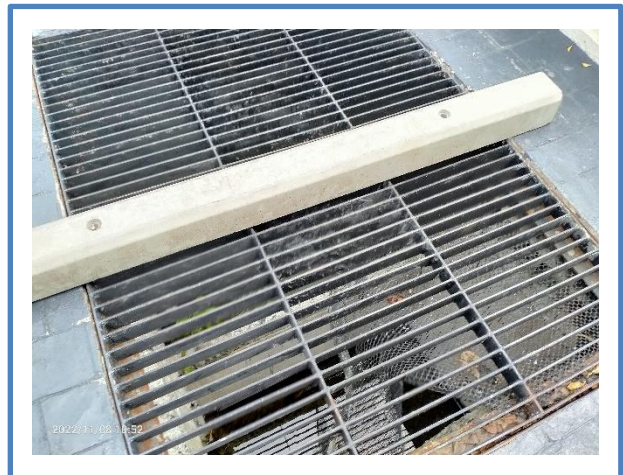
รูปที่ 2.3-3 ตะแกรงดักขยะมูลฝอย
