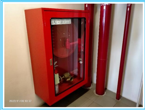
รูปที่ 3-45 ชุดตู้ดับเพลิง
