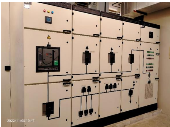
รูปที่ 2.3-9 แผงจ่ายไฟหลัก (Main Distribution Board, MDB)
