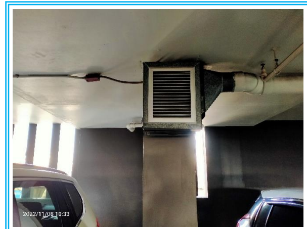
รูปที่ 3-5 พัดลมดูดอากาศบริเวณชั้นที่จอดรถ
