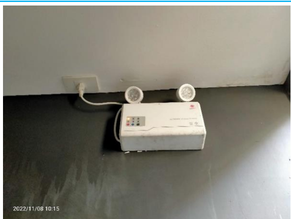
รูปที่ 3-51 ไฟฟ้าส่องสว่างฉุกเฉิน
